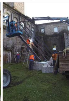
2016 Traballos de reposición para o tellado e muro cara ao sur
