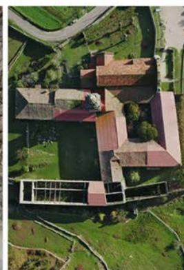
2018 Retirada da cuberta do Ala Norte colapsada
