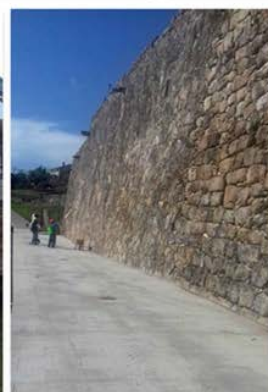
2017 Muro de contención que enfrenta o mar.
