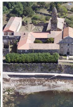
2005-2006 Acométense os primeiros traballos de desescombro, reposición de cubertas caídas e apuntalamiento de fachadas.
