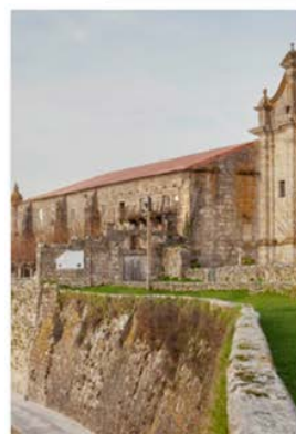
2010 Reposición da parede perimetral
