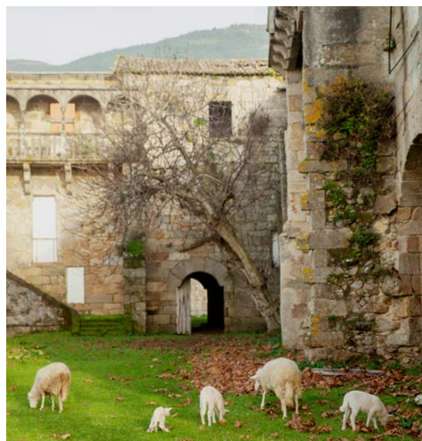
A figueira do Mosteiro de Oia
